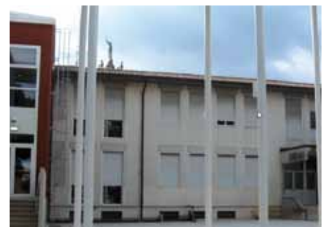
Completamento fasi di cantiere
