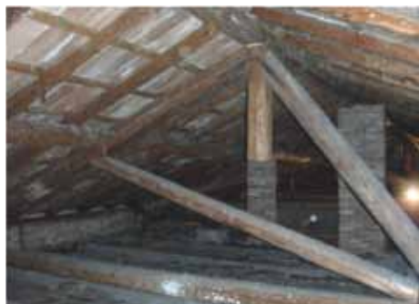
Rilievo del sottotetto: sopralluogo
