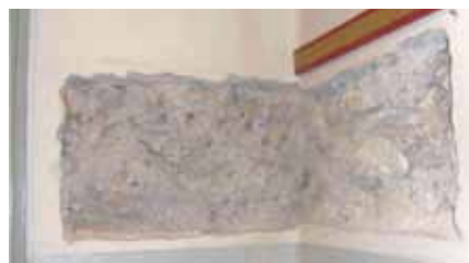
Rilievo sui materiali: elementi lapidei calcarei di forma irregolare allettati con malta. Spessore intonaco 2.5 cm
