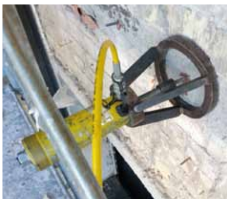
Esecuzione delle prove di pull-out su calcestruzzo
