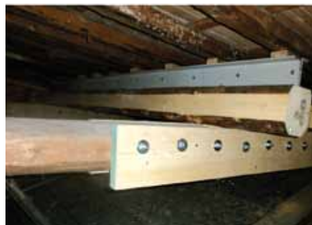
Rinforzo delle travi in legno con tavoloni metallici e barre passanti-integrazioni delle sezioni lignee
