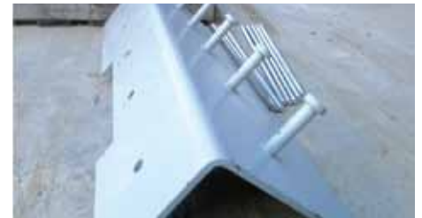
Realizzazione cordolo: angolare utilizzato
