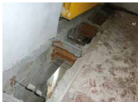
Rinforzo delle travi in legno con tavoloni metallici e barre passanti-integrazioni delle sezioni lignee
