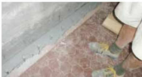
Realizzazione cordolo: foto finale posa cordolo metallico piolato con integrazione di getto in cls
