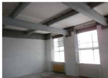
Travi in acciaio per il rinforzo dei solai impalcati intermedi
