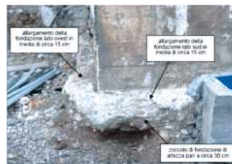
Foto di dettaglio della fondazione angolo sud-ovest
