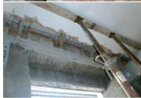
Realizzazione cordolo: smembratura dell'esistente
