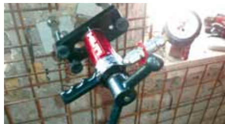
Esecuzione delle prove di pull-out su muratura
