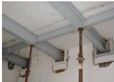
Travi in acciaio per il rinforzo dei solai- fase di messa in tensione
