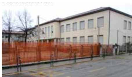
Foto del cantiere
